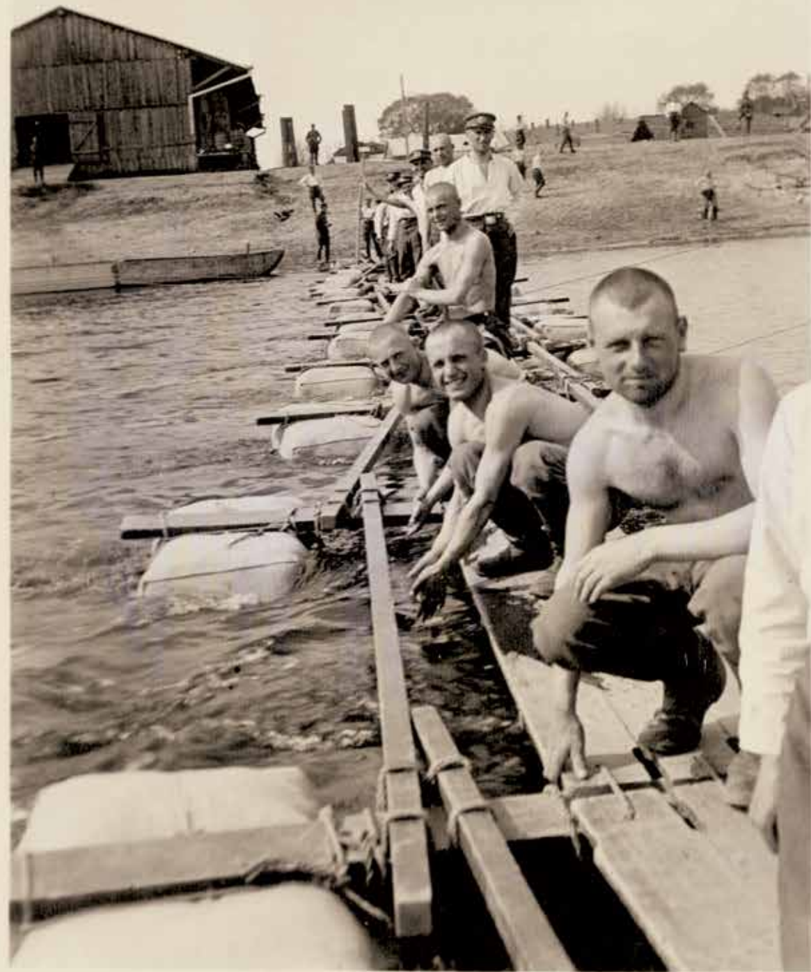
Kariūnai atlieka inžinerijos praktiką – stato plūdinį tiltą, 1934 m. gegužės mėn. nuotrauka
