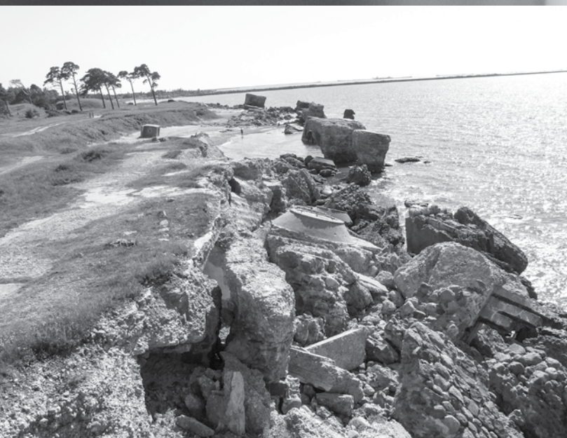
Įspūdingieji Baltijos jūros plaunami pakrančių apsaugos baterijų griuvėsiai Liepojoje
