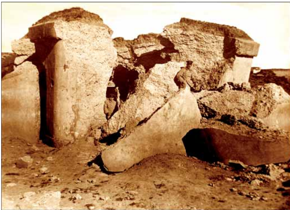
52. I gynybos skyriaus forto sugriautas betoninis statinys. 1915 m. VDKM
